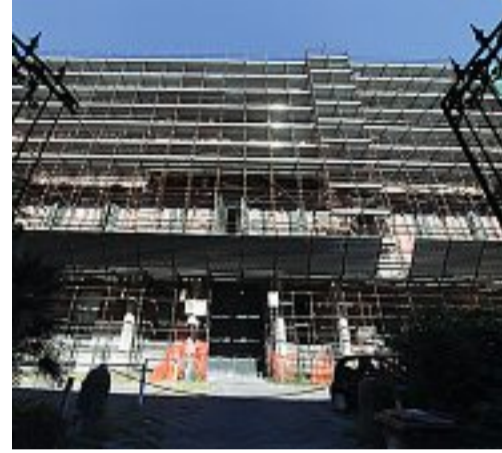
L'edificio Palazzo d'Avalos in via dei Mille
